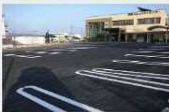
起工第141号筑紫コミュニティセンター外構2期工事
