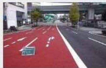
一般国道385号道路舗装工事
