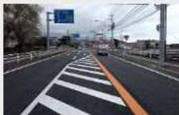
福岡西維持管内舗装修繕工 事
