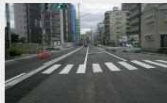
都市計画道路博多箱崎線外1線(千代・馬出)道路舗装工事(その3)
