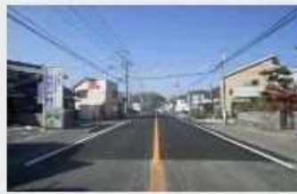
令和3年度 福岡西維持管内舗装修繕工事
