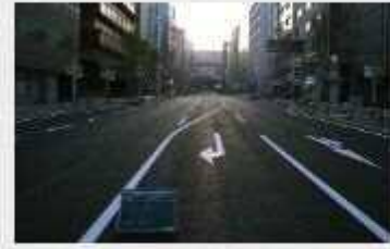
博多駅前線(はかた駅前通 り)車道舗装工事
