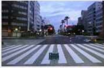
県道博多港線舗装補修工事 (蔵本交差点)
