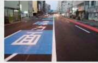
令和3年度 福岡西維持管内舗装修繕外工事
