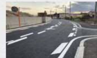
那珂2045号線道路舗装工事
