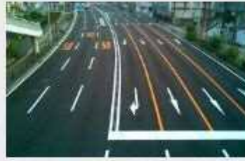
国道3号福岡維持管内舗装繕 繕工事
