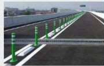
福岡208号 徳益高架橋舗装 工事
