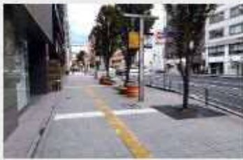
博多駅前線（はかた駅前通り）歩道舗装工事
