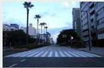
県道博多停車場線舗装補修 工事
