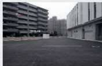
起工第9号消防本部・筑紫野 消防署外構舗装工事
