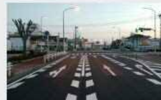
令和2年度 福岡南部地区付属物設置外工事
