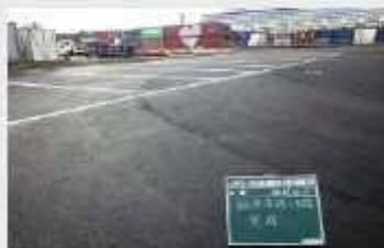
中央ふ頭先端部（東）公園 広場舗装工事
