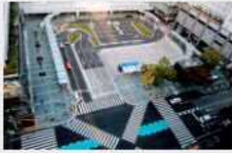
博多駅筑紫口駅前広場再整備工事 (JV)
