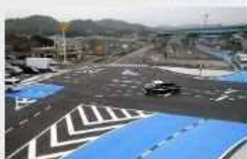
平成26年度 立花寺北交差 点改良外工事
