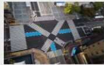
国道385号（竹下通り）道路舗装工事
