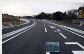
福岡志摩前原線 道路舗装 工事
