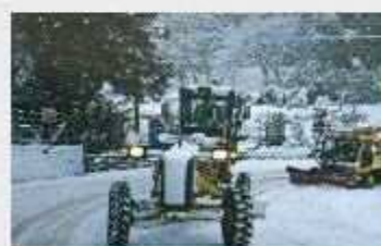
福岡地区道路維持修繕工事
