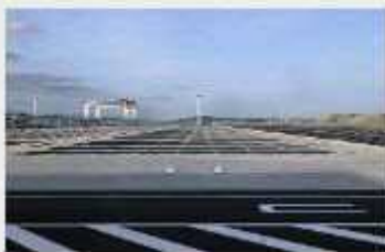
アイトシティ地区C2コンテナターミナル整備工事（JV）
