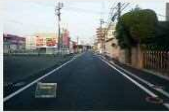
県道東光寺竹下春吉線外1路線道路舗装工事
