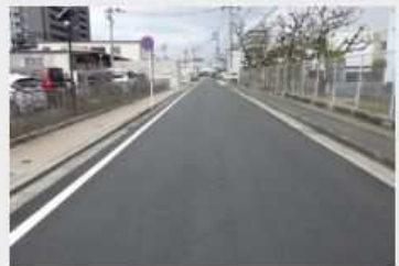
那珂校区舗装補修工事（その4）
