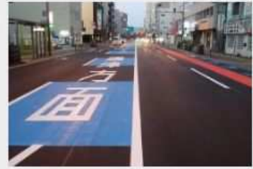
令和3年度 福岡西維持管内舗装修繕外工事
