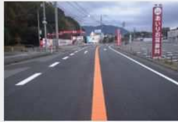
県道福岡太宰府線 道路舗装補修工事（3工区）
