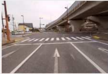
令和6年度 福岡西維持管内交通安全施設設置工事
