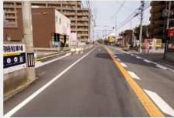
令和6年度 池田地区歩道整備 外工事
