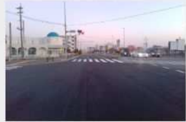
県道福岡東環状線外 道路舗装 補修工事（2工区）
