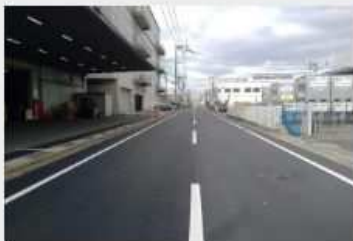
榎田2235号線外7路線舗装 補修工事
