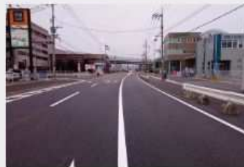
都市計画道路国道3号線（板付） 道路舗装外工事
