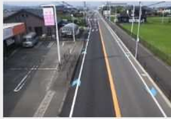
令和3年度 福岡南部地区交通安全対策工事
