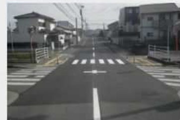
日の里団地線舗装打換工事
