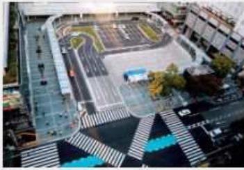
博多駅筑紫口駅前広場再整備工事 (JV)
