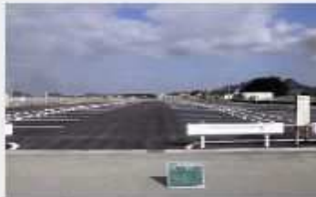
福岡漁港駐車場整備工事
