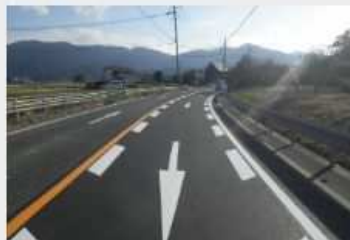
令和3年度 福岡西維持管内舗装修繕工事
