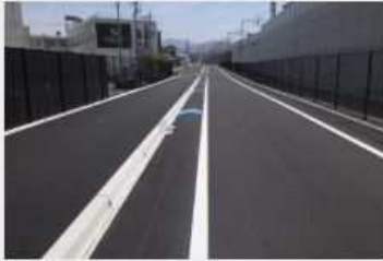
西鉄天神大牟田線側道16号線 道路舗装工事（その3）
