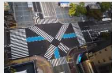
国道385号 (竹下通り) 道路舗装工事
