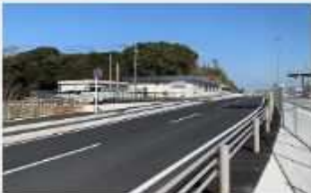
今宿道路 多久地区舗装外工 事
