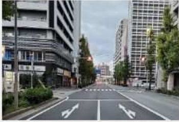
県道松原比恵線舗装補修工事
