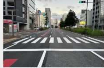
博多駅草ヶ江線(住吉通り)自転車通行空間整備工事(その2)
