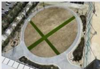
福岡大学A駐車場跡地（正門北側）整備工事
