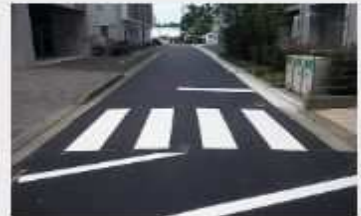
福岡大学9号館東側歩道舗 装他改修工事
