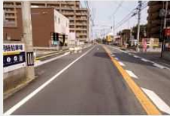
令和6年度 池田地区歩道整備 外工事
