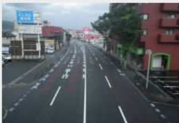
令和5年度 福岡北部地区交通安全施設設置工事
