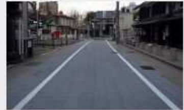
冷泉町288号線道路舗装工事
