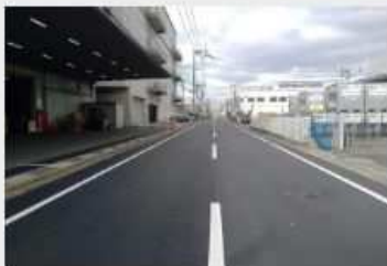
榎田2235号線外7路線舗装 補修工事
