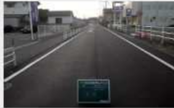
弥生校区舗装補修工事（そ の3）
