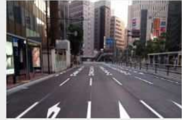
福岡市地下鉄七隈線博多駅道路舗装工事 (その2)
