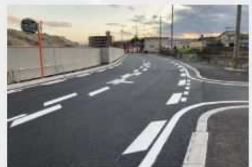
那珂2045号線道路舗装工事
