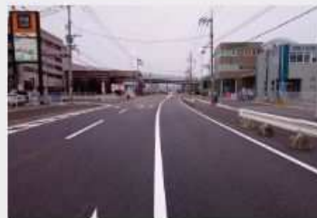
都市計画道路国道3号線（板付） 道路舗装外工事
