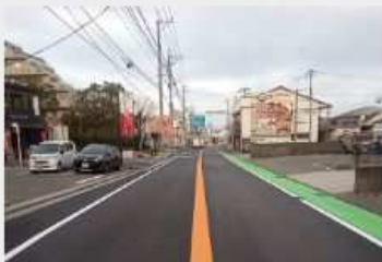
県道福岡太宰府線 道路舗装補修工事 (1工区)
