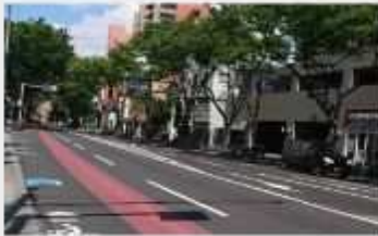
平成30年度 福岡西維持管内 舗装修繕工事
